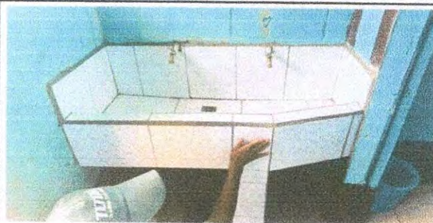
Foto 12 Sustitución de lavamanos
