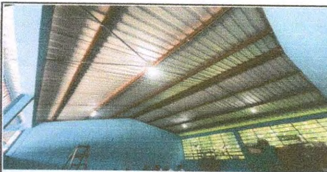
Foto 5 Reparación de Sistema Eléctrico
