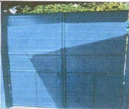
Foto 3 sustitución de portón
