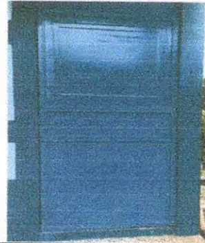
Foto 2 Sustitución de puerta
