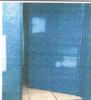
Foto 11 Sustitución de puertas
