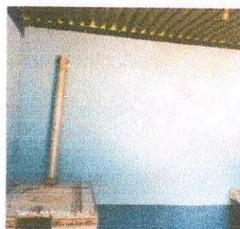
Foto 18 Pintura de interior de cocina
