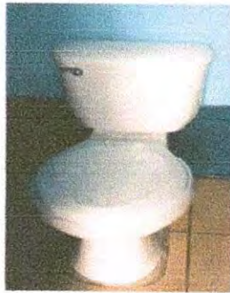
Foto 1 Sustitución de baños y accesorios
