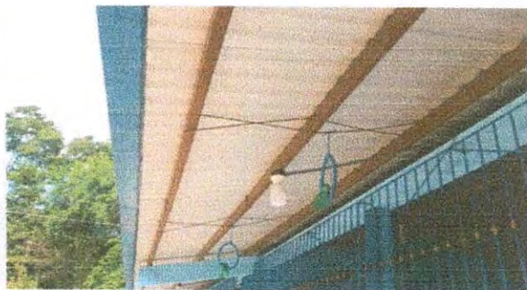
Foto 13 Reparación de Sistema Eléctrico exterior
