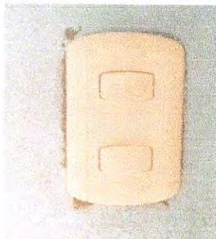
Foto 7 Sustitución de apagador
