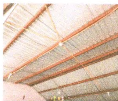
Foto 14 Reparación de Sistema Eléctrico interior
